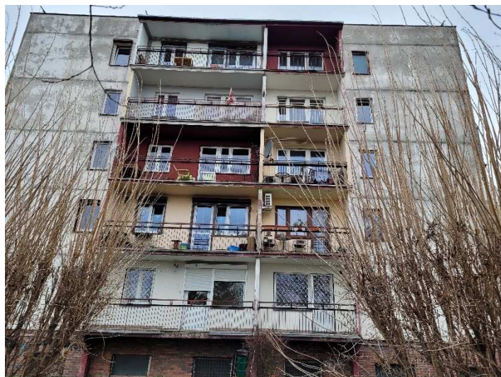
Fot. 2. Elewacja południowo-wschodnia
