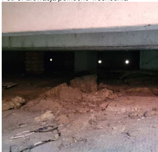
Fot. 5. Przestrzeń stropodachu
