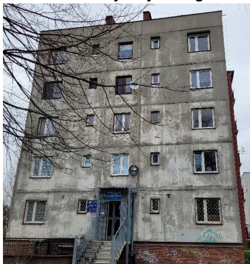
Fot. 1. Elewacja południowo-zachodnia
